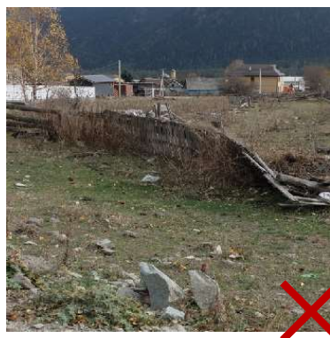
оставлять неиспользуемые ограждения, особенно в разрушающемся виде
