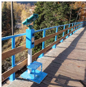
Ограждение на мостах:
