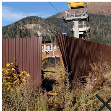
оставлять неиспользуемые ограждения, особенно в разрушенном виде
