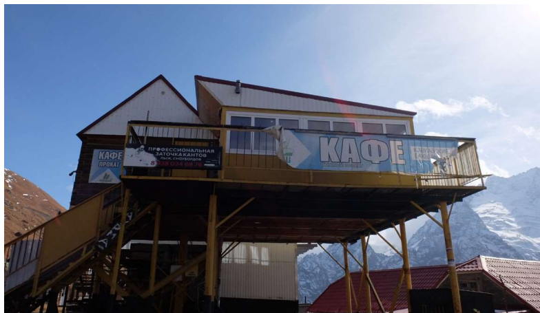
Хаотичные надстройки и выступающие элементы фасадов
